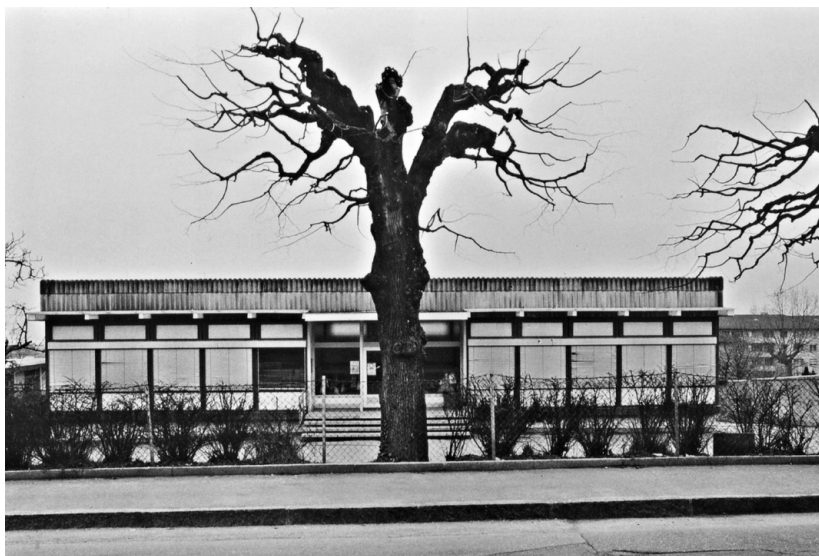
Un des deux pavillons construits à la route de Colovrex en 1962.
