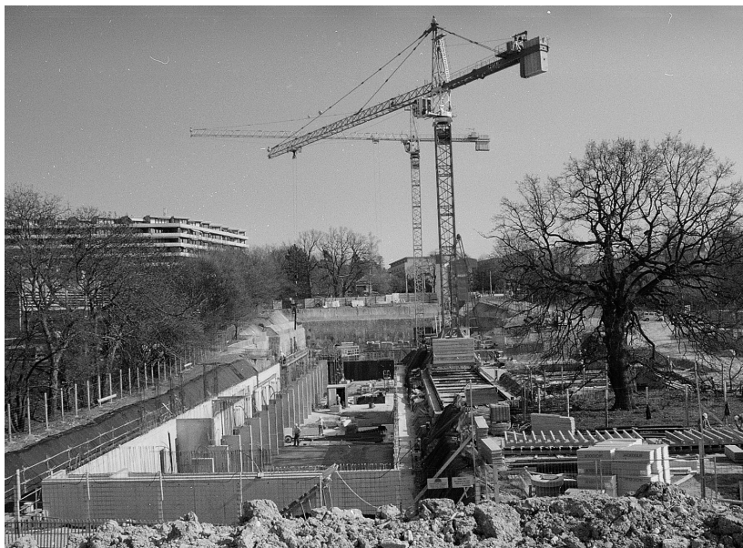
Fondations de l'école du Pommier, 2003.
